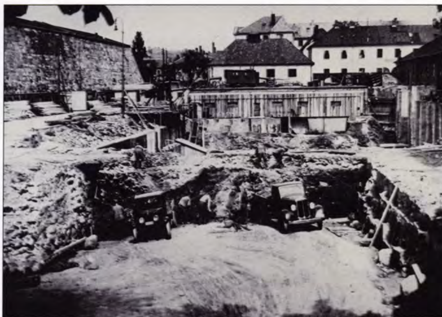
Forberedende anleggsarbeid ved Festningen renseanlegg på 1930-tallet.
